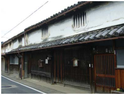
竹林家 (江戸末期安政年間建造) 醤油醸造と網屋、質屋を営んでいた元商家 虫籠窓、厨子二階、1階は大戸口と格子 江戸後期の町家の特徴を良く示す。
